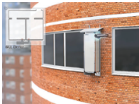
Монтаж на вертикальной раме на улице. Способ 2.
